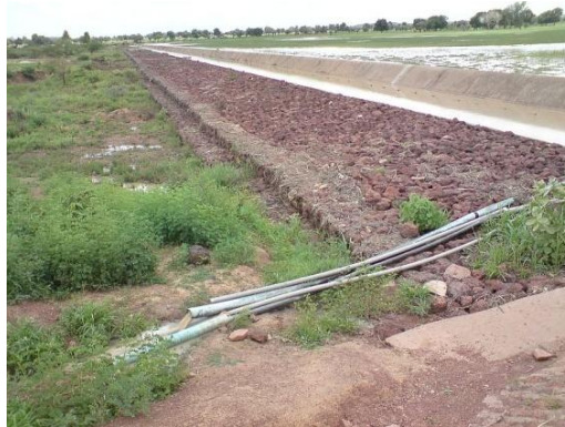
Photo 7 :/ mise en place de siphons au droit de la digue pour développer une irrigation « parallèle » (photo Hilmy Sally)
