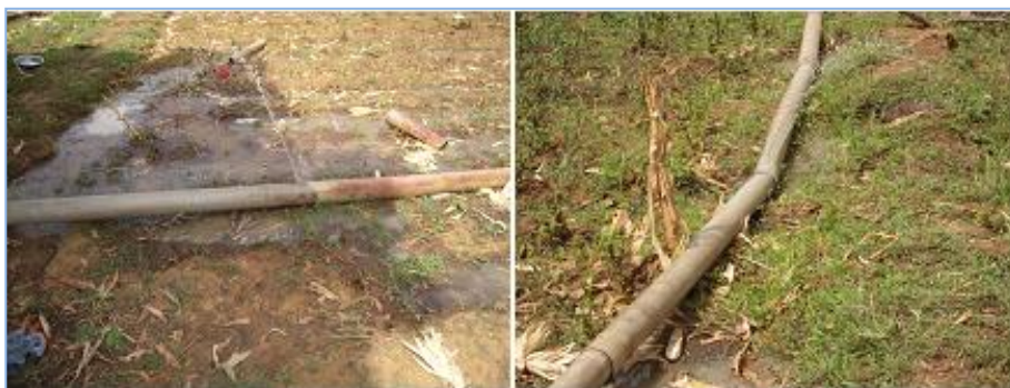
Figure 5: Dégradation des canalisations
