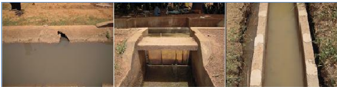
Figure 7: Fuites et prélèvements identifiés sur le réseau de Mogtédó
